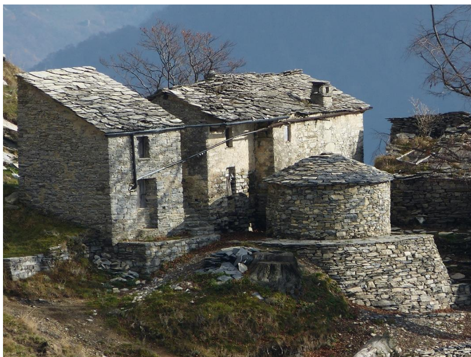
Esempio di restauro di tetti in piode ed edifici rurali nel vicino alpe di Nadigh realizzato dal MEVM nel 2012
