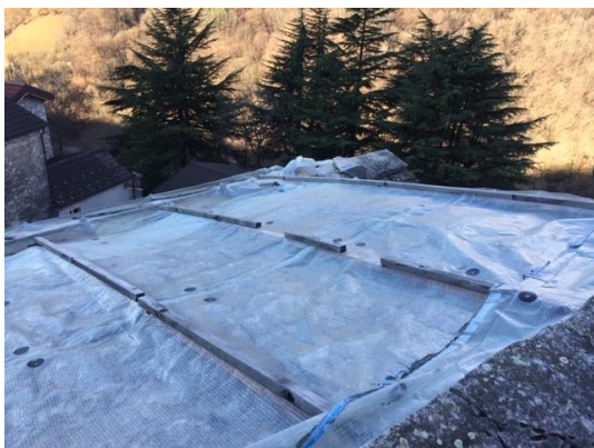
Posa di teloni per arginare le infiltrazioni
