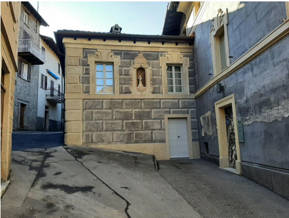
Facciata dell'ala sud di proprietà privata recentemente restaurata..
